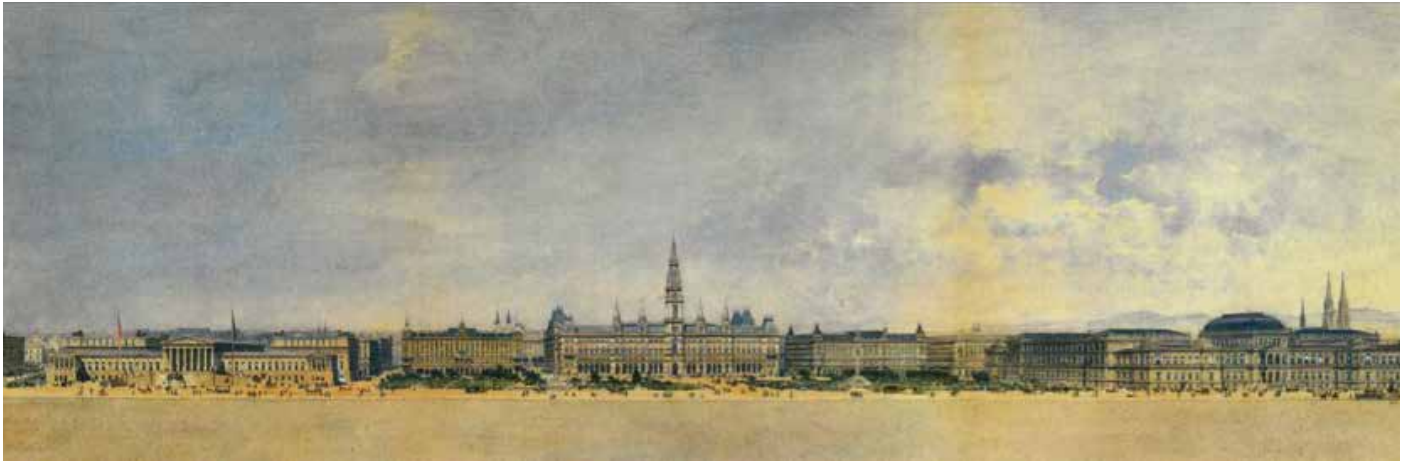
Rudolf von Alt: gebouwen aan de Ringstraße, 1873.
