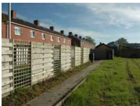
deel van de verouderde woonwijk is gesloopt
