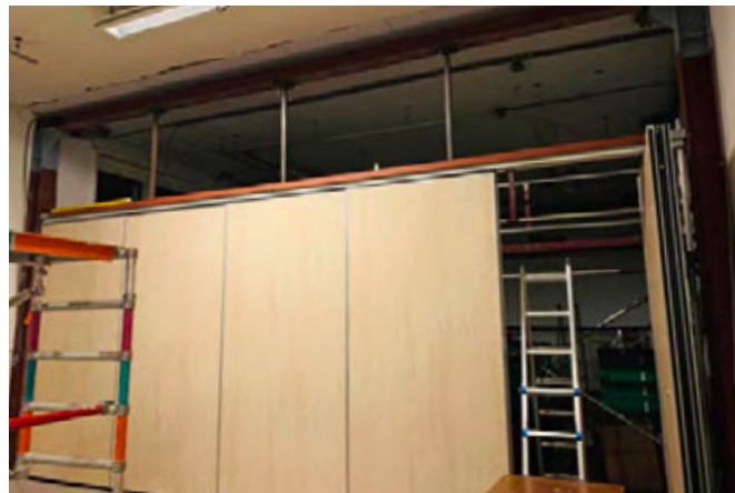
GEBOUW NOG NIET ENERGIE NEUTRAAL
